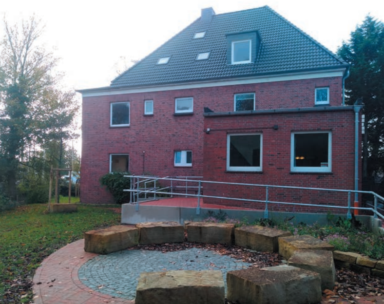
Das fertige Außengelände mit barrierefreiem Zugang (Rampe) zum Tagesaufenthalt.
