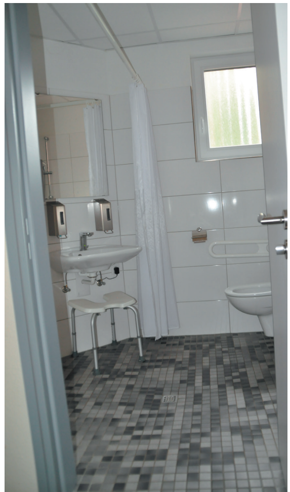
Neue barrierefreie Sanitäranlagen.
