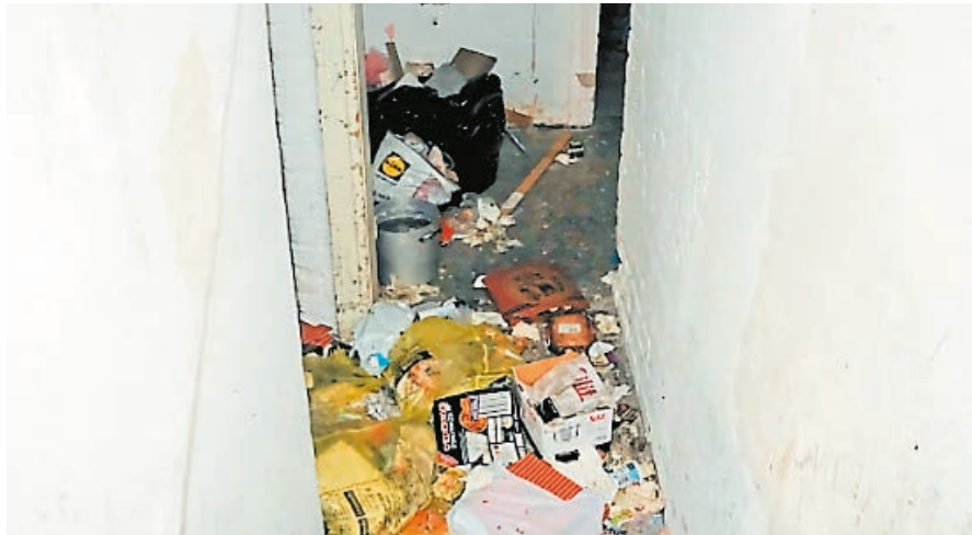
Bilder aus einem Haus in Barenburg: Vollgemüllter Keller, aufgebrochene Briefkästen, Loch im Kellerdach der besuchten Wohnung. Die Fotos wurden im September gemacht. Inzwischen wurden diverse Mängel in dem Haus beseitigt. Fotos: Eric Hasseler
