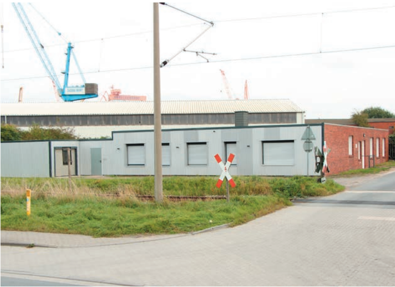
Neue Front des Gebäudes nach dem Umbau. Der Eingangsbereich wurde komplett versetzt.
